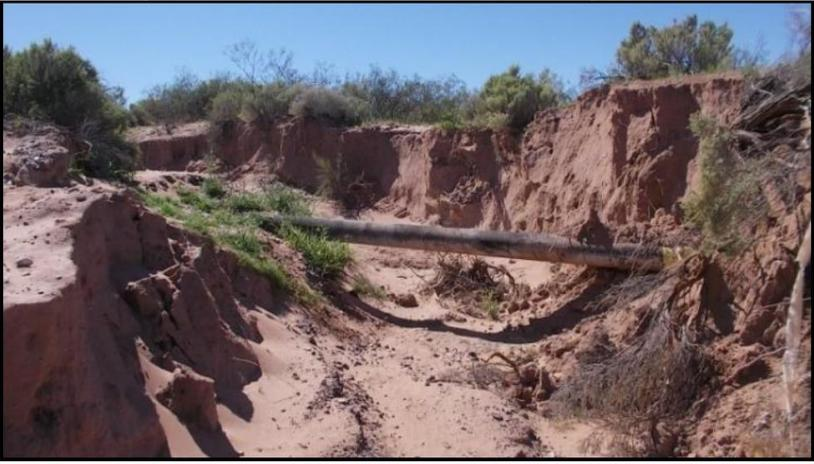
Fotografía N° 1: Vista del ducto expuesto por el cauce.
