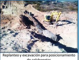
Replanteo y excavación para posicionamiento de colchonetas
