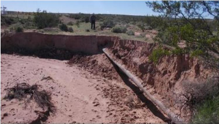
Fotografía N° 4: Vista ducto expuesto a la erosión.
